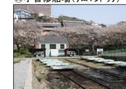
日本最初の近代的洋式ドックで国指定史跡。現在の造船長崎の発祥の地ともいえる。船を引き揚げる滑り台がソロバン状に見えるためソロバンドックと呼ばれる。
