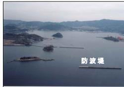
外洋の高波から港を守り、港内を静穏に保つ防波堤。海底水深が35mと深いため、重量4千トン、高さ22m、幅13m、長さ20mの巨大なケーンソーンで建設されている。
