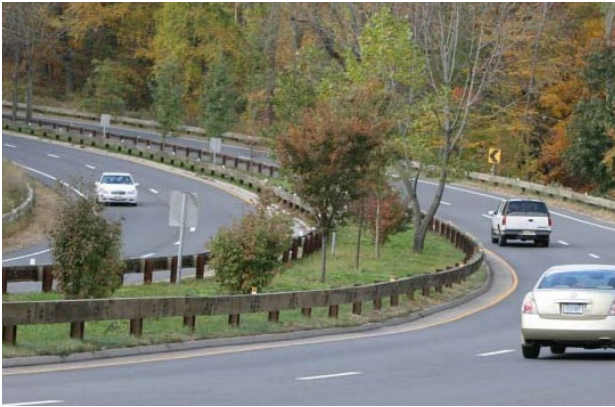
写真-1 メリットパークウェイの木製ガードレイル
