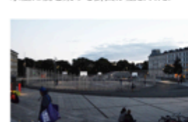
(4) 2014 年 Israels Plads 2008 年設計コンペ、敷地横のマーケットと併せて、駐車場だった場所にスポーツ施設が整備された。地下には1150台の駐車スペースが新設された。
