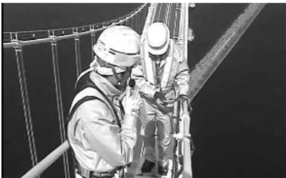
写真-9 点検状況（吊橋ケーブル上）
