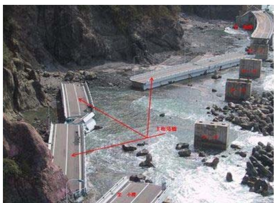
台風による高波で落橋した大森大橋
