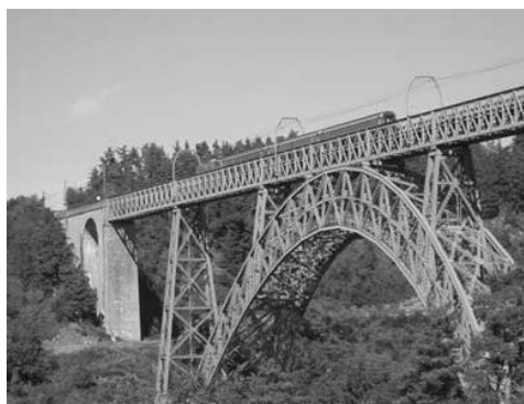
写真－1 Garabit Viaduct (1884)
