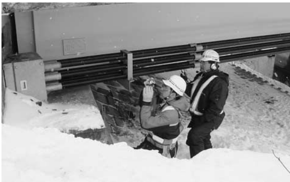
写真-8 点検状況（冬期）
