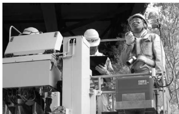
写真-7 点検状況
