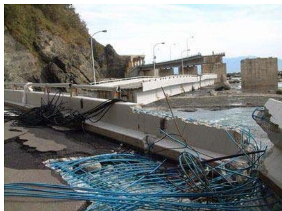
台風による高波で落橋した大森大橋
