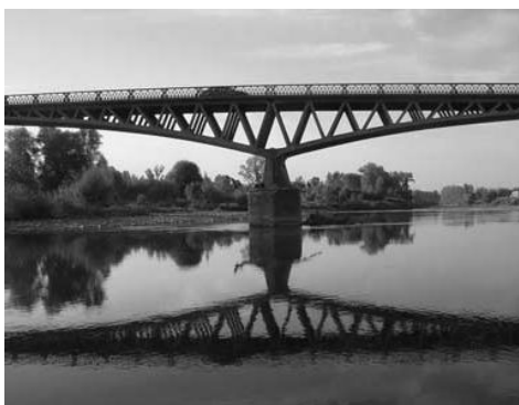
写真－2 Pont de Boutiron (1912) と高欄の状況（右）
