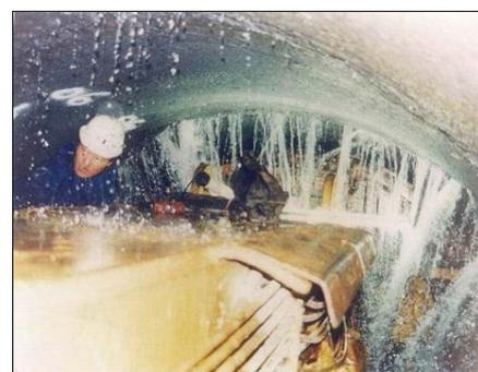
写真-2 下流導水路の湧水状況
