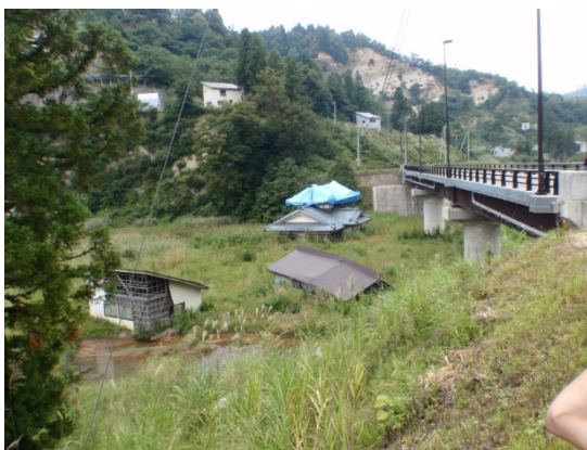
水没した家屋と土砂流出状況
