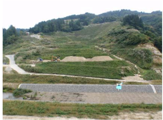
寺野の地すべりと対策工
