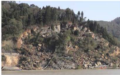
妙見(白岩)の岩盤崩壊(2004/10)
