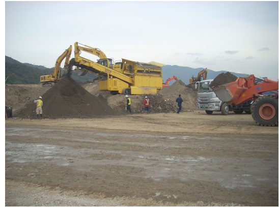
災害発生土の中間処理状況（呉市：18.11.16）
