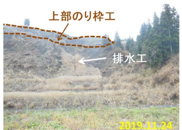
写真3.1-6 15年後の斜面復旧状況
