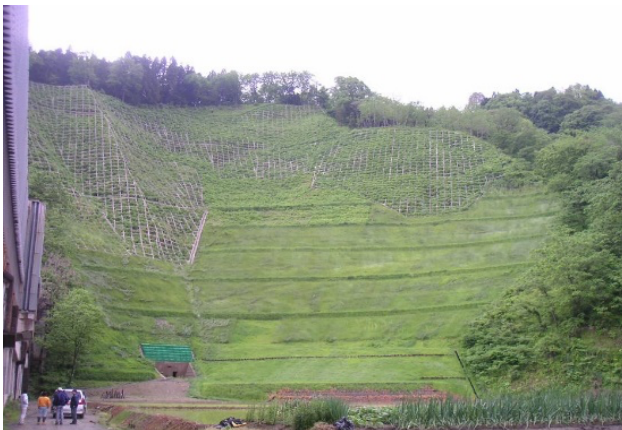
写真 3.2-12 対策工 左側斜面
