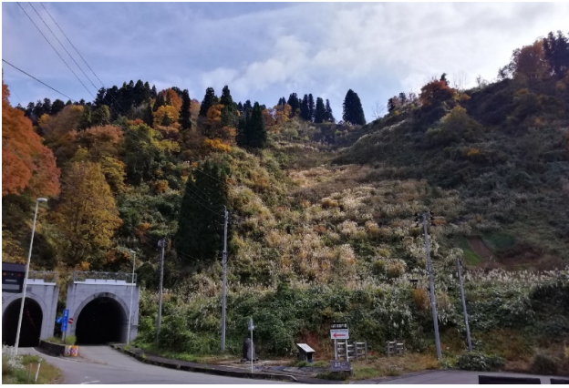
写真 3.2-26 15年後の状況 遠景
