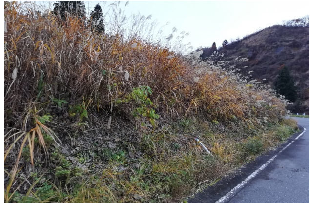
写真 3.2-44 侵入定着したススキ草原になっている 低木類の侵入・定着が認められる
