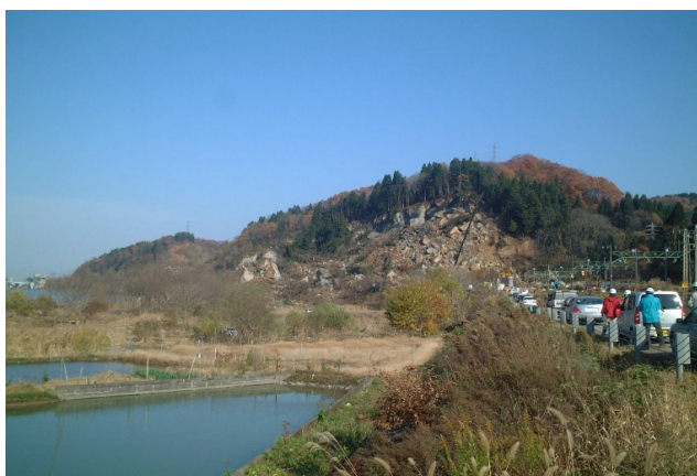
写真 3.2-1 崩壊状況 平成16年10月
