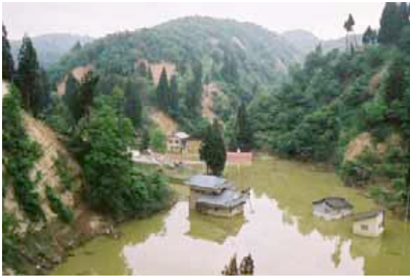
図 3. 4-3 斜面崩壊による芋川の閉塞で水没した木籠集落 (2005. 5. 31)
