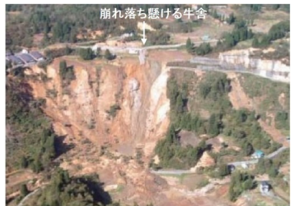
写真3.1-4 被災時の斜面崩壊(新潟県)
