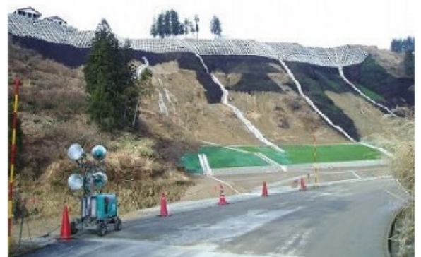
写真3.1-5 復旧対策施工時(新潟県)
