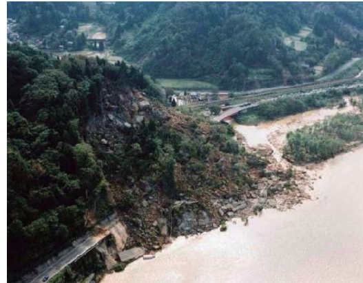
図 3. 4-5 北側からみた崩壊状況 (委員会資料、新潟県提供)
