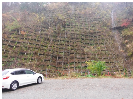
写真 3.1-15 15年調査時の吹付けのり枠工の状況 (R1. 11. 24)
