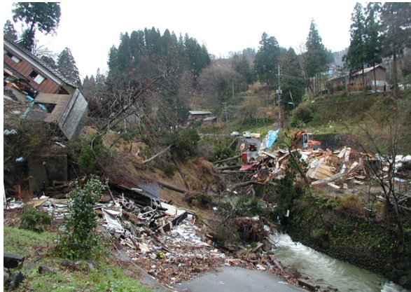
写真 2-6 濁沢地区の地すべり (H16. 11. 28 末端状況)
