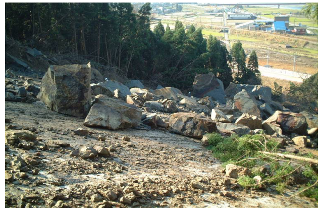
写真 3.2-7 崩壊状況 平成 16 年 10 月 岩盤すべり状況
