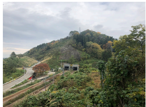
図 3. 4-6 南側からみた復旧状況 (2018. 11. 7)
