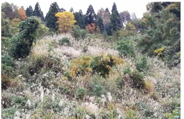
写真 3.2-9 15 年後の状況 すべり面への植生定着状況
