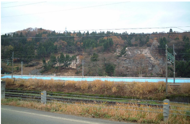
写真 3.2-6 崩壊状況 平成 16 年 10 月 遠景
