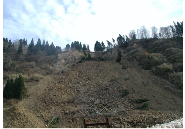
写真 2-12 竹沢地区羽黒トンネル坑口の深層崩壊 H16.11.26 撮影
