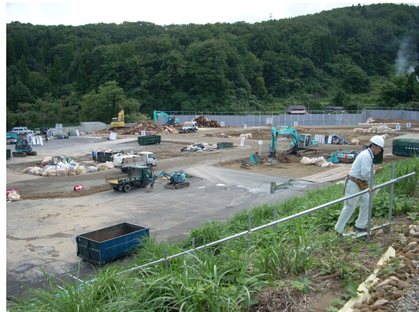
写真 3.5-4 中越沖地震時の仮置き場：アスファルトと砂利敷きでたまり水を削減（刈羽村 : 07. 9. 18)
