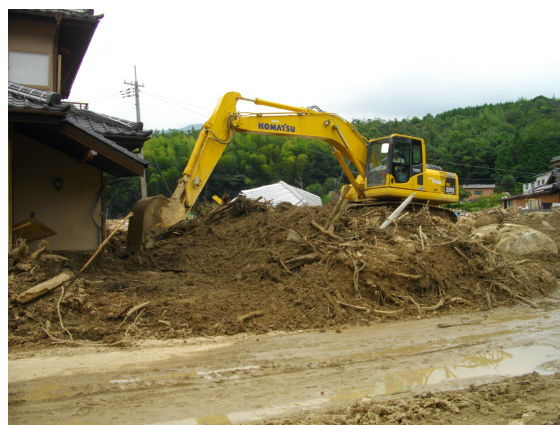
2009年山口土砂災害：災害発生土(防府市：09.8.1)
