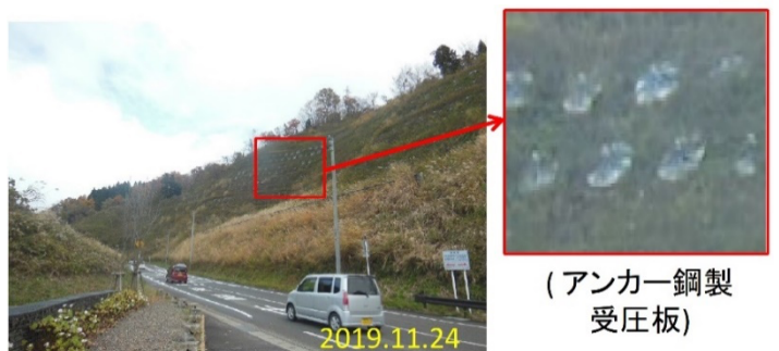
写真 3.1-3 災害から 15 年後の斜面復旧状況
