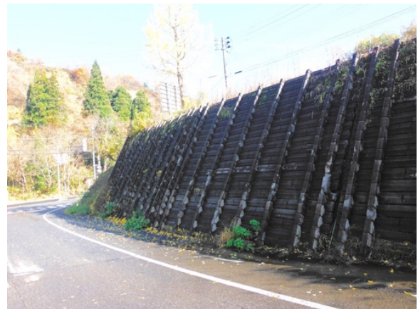
写真 3.1-10 15 年後の井桁擁壁 (南荷項地区 R1.11.24)
