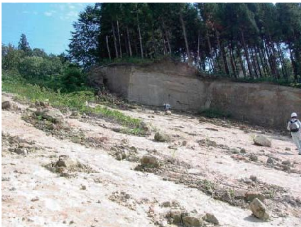
図 3.4-7 崩壊状況 (学習マップ)
