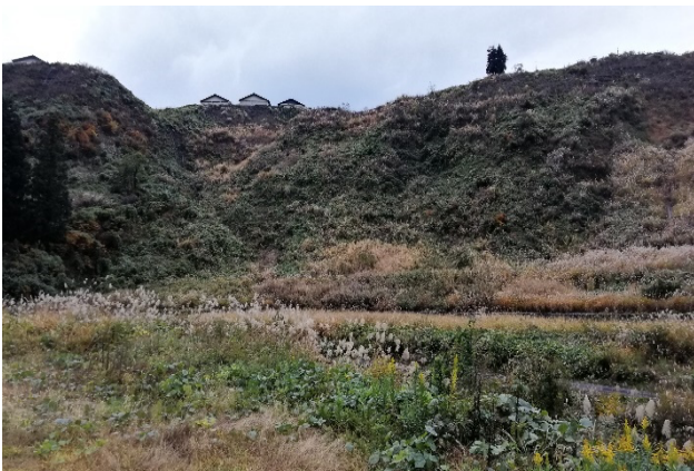
写真 3.2-30 15年後の状況遠景
