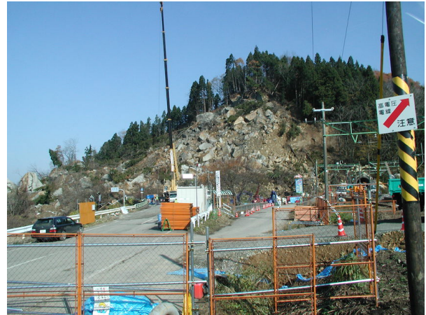
(b) トンネル坑口側状況 (H16.11.26 撮影)
