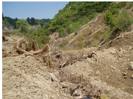
中越地震：河道閉塞させた土砂(旧山古志村：05.5.21)
