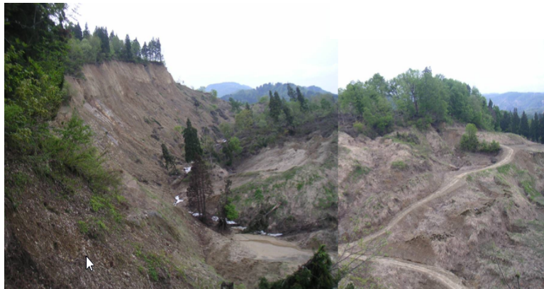
写真 3.2-17 崩壊状況 平成 16 年 10 月
