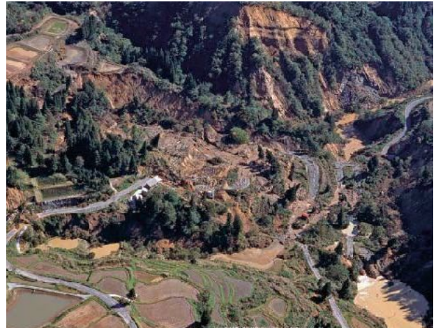
図 3.4-17 上流側からの地すべり発生状況 (アジア航測株式会社提供)
