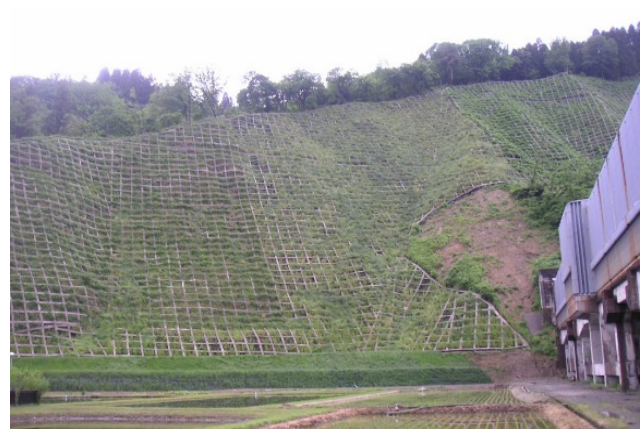
写真 3.2-13 対策工 右側斜面
