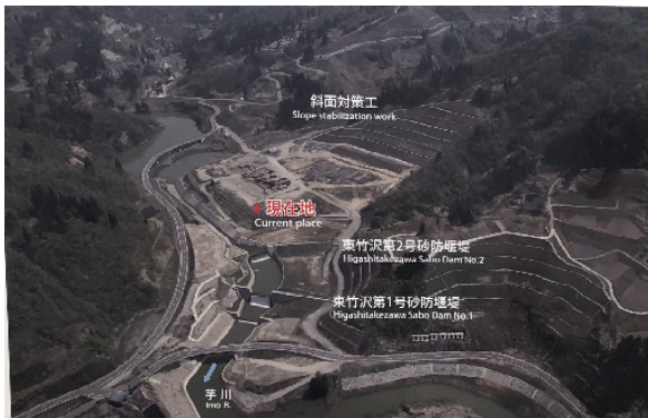
図 3.4-16 復旧状況 (国土交通省北陸地方整備局湯沢砂防事務所)
