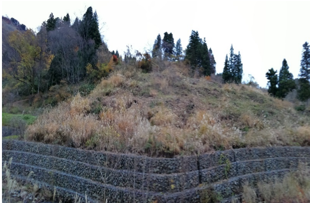
写真 3.2-39 15 年後の状況 遠景
