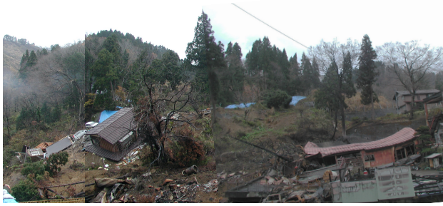
写真 2-4 濁沢地区の地すべり全景 (H16. 11. 28 対岸からの撮影)
