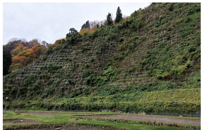
写真 3.2-15 15年後の状況 左側斜面
