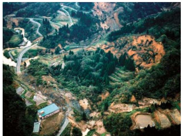
写真 2-3 東竹原地区の地すべりと天然ダム 2)
