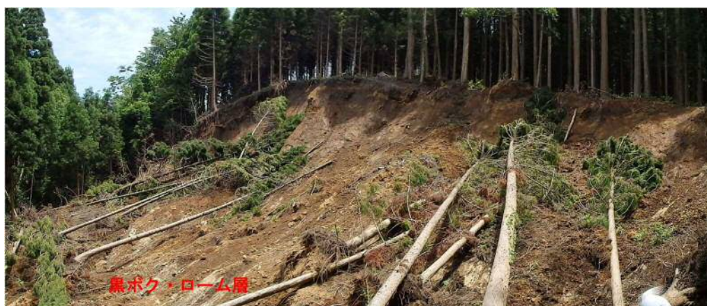
写真 3.1-22 斜面上部の表層崩壊状況（写真 3.1-21 の左側崩壊の頭部）
