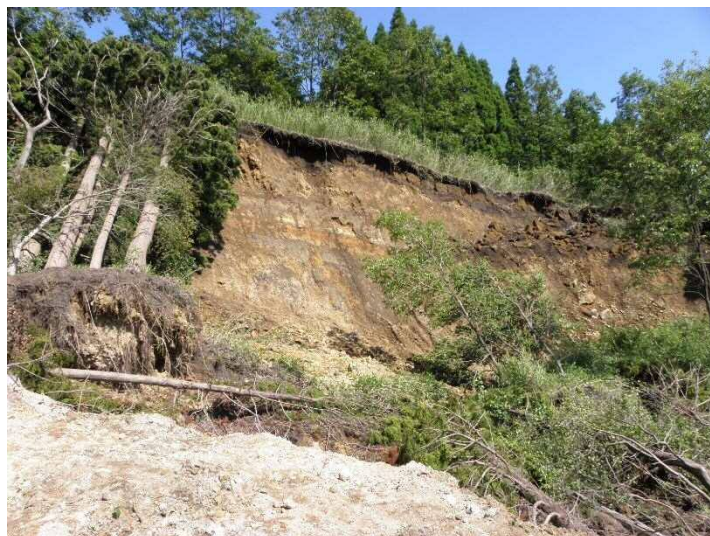
写真 3.1-11 ②崩壊箇所全景
