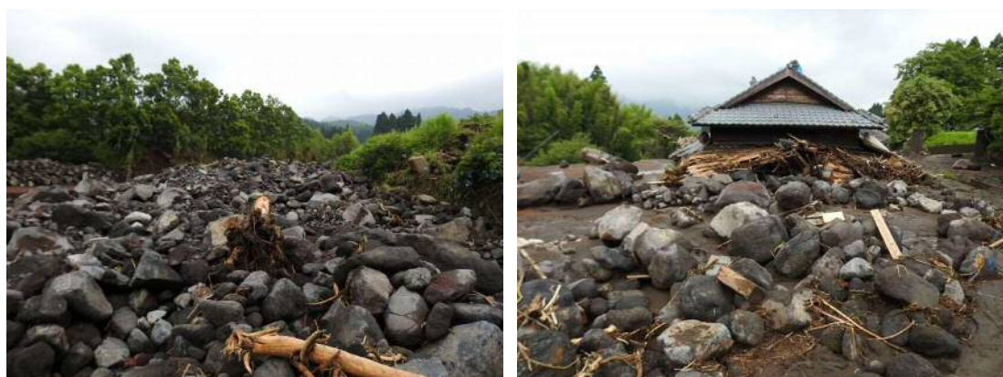
写真 3.1-23 土石流堆積状況（新畑橋直上流，6/21撮影）
