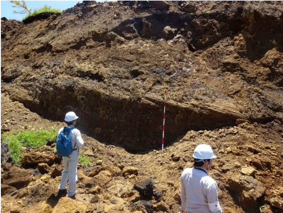
写真 3.1-3 側方崖（崩壊時の土塊の擦跡が残る）
