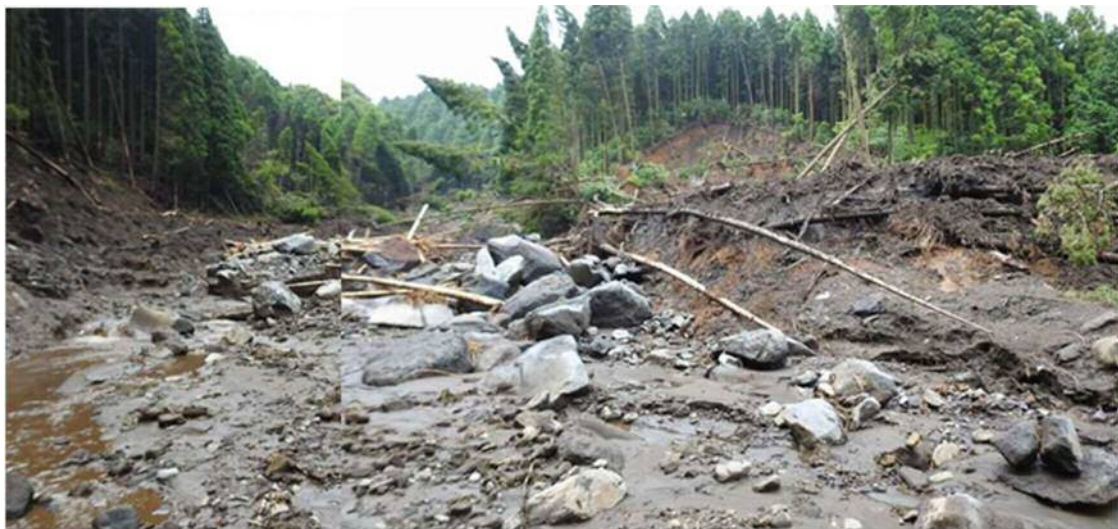
写真 3.1-25 山王谷川砂防堰堤堆砂状況 (6/21 撮影)
