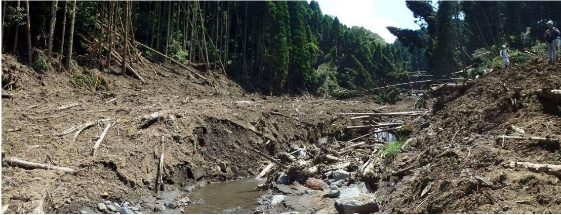
写真 3.1-24 山王谷川砂防堰堤堆砂状況 (6/3 撮影)
