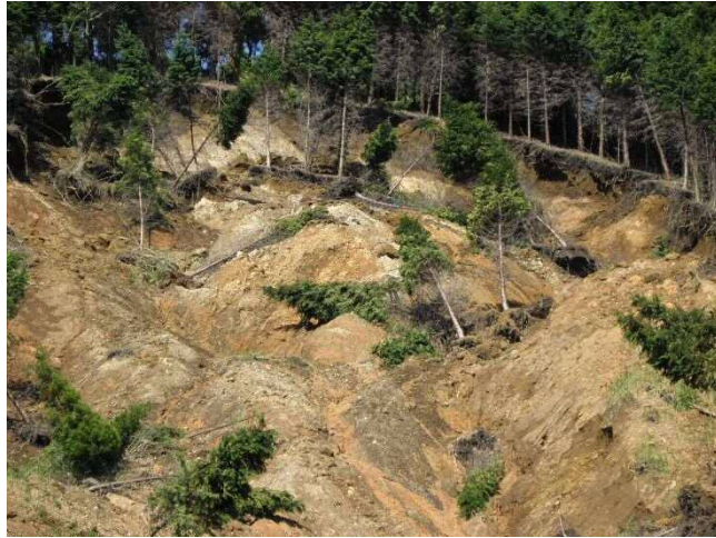
写真 3.1-13 ①崩壊頭部
