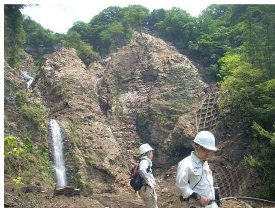
写真 3.1-27 山口旅館東側の崩壊状況（近景）
