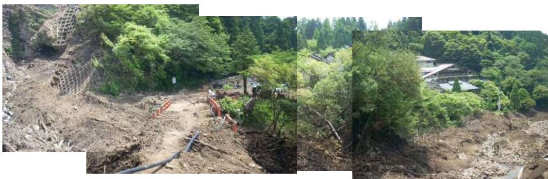
写真 3.1-29 垂玉川上流の急崖からの土石流の状況 山口旅館（写真右の家屋）には達していないが、道路等は通行できない状況となっている。
