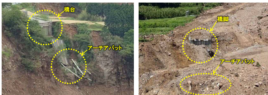
図 3.1-11 左：左岸側橋台とアーチアバット，右：右岸側橋脚とアーチアバット
