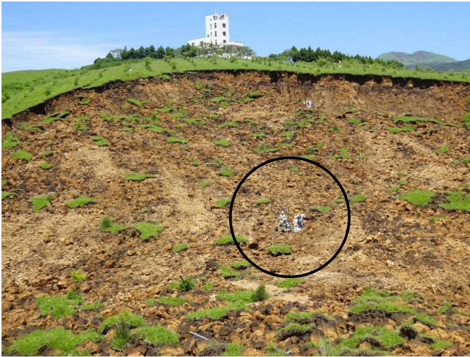
写真 3.1-6(a) 崩壊部の底部に露出したすべり面
