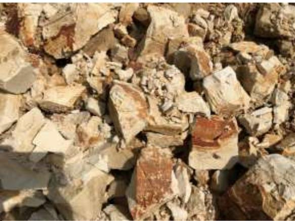
岩質はシルト岩あるいは砂岩とみられ、比較的均一な土層のため崩壊規模が大きくなったものと考えられる。
