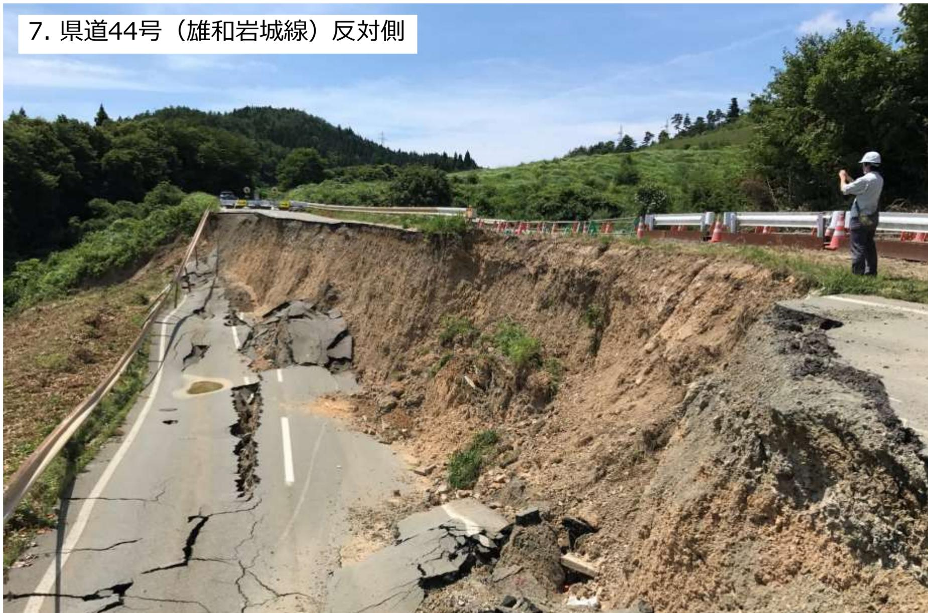
秋田県の山間部の古い道路には同様な施工が多い。盛土材の土質特性・状態と排水設備の状況を調査する必要がある。
