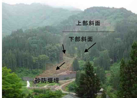
写真-4.2.1.5.2 カクレ沢の全景 (対岸の八方岩の地すべりからの遠望)
