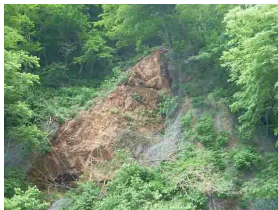
写真-4.2.1.3.7 C地点の斜面崩壊部の拡大
