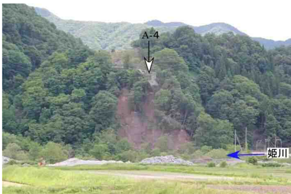
写真-4.2.1.1.3 崩壊A-4の全景
