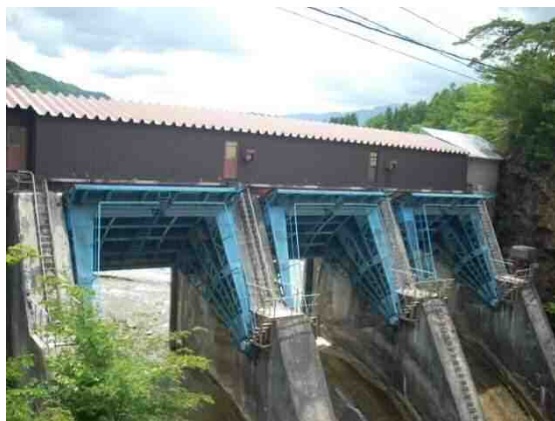
写真-4.2.2.3.1 姫川第二ダム（平成 27 年 6 月 20 日撮影）
