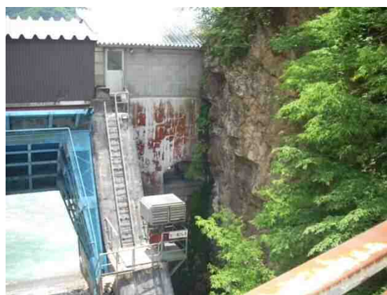
写真-4.2.2.3.4 ダムの左岸部
