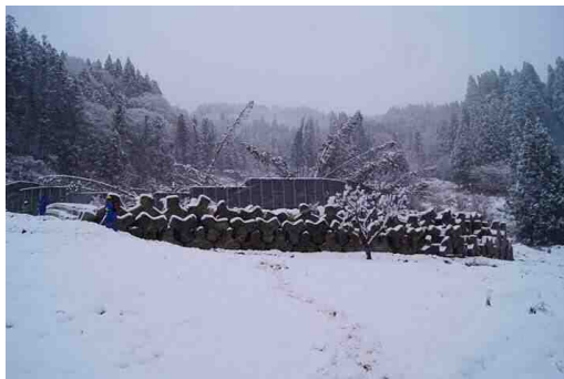
写真-4.2.2.1.3 小谷村中谷東地区地すべり
