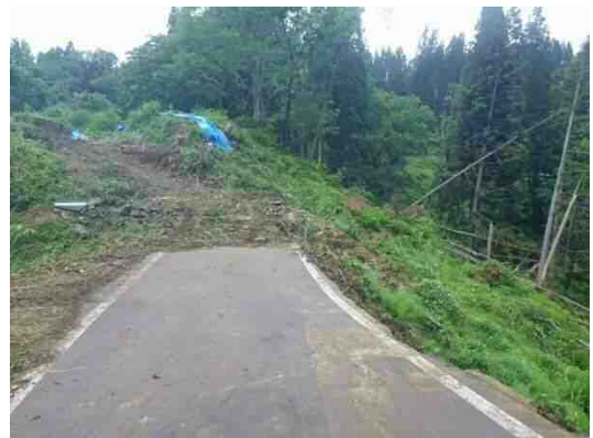
写真-4.2.1.6.6 西ブロック2の2次崩落
