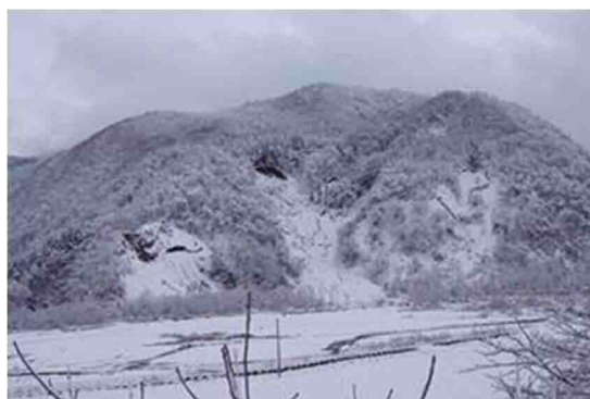
写真-4.2.2.1.6 姫川第2ダム直上流左岸部の崩壊
