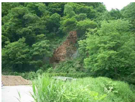
写真-4.2.1.3.6 C地点の斜面崩壊全景
