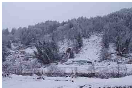
写真-4.2.2.1.4 小谷村中谷西地区地すべり
