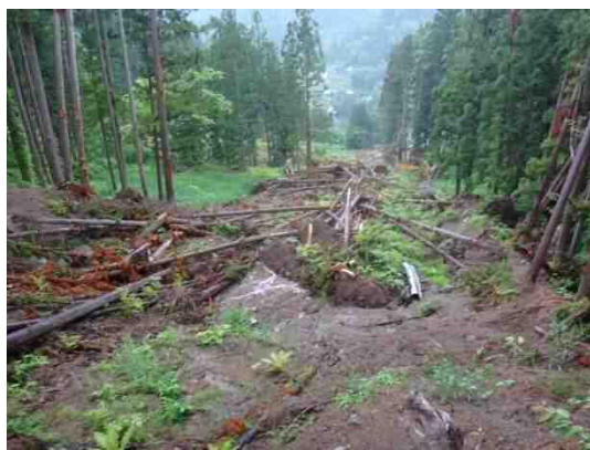
写真-4.2.1.5.6 被災したコルゲート水路
