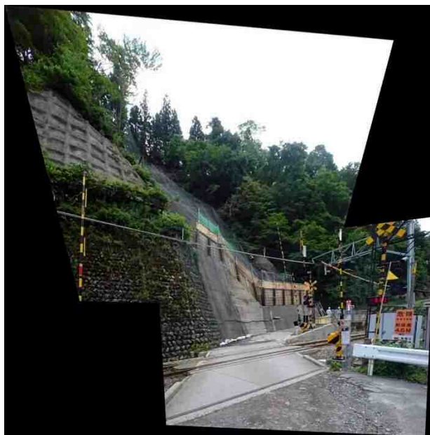
写真-4.2.1.4.2 地すべり末端部の擁壁および吹付法 枠工に新しい変状無し
