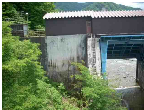
写真-4.2.2.3.5 ダムの右岸部
