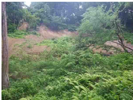
写真-4.2.1.6.2 中央ブロック頭部の滑落崖
