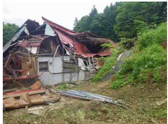
写真-4.2.1.6.5 西ブロック1末端の押し出し（土砂によって潰された民家）
