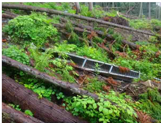
写真-4.2.1.5.6 被災したコルゲート水路
