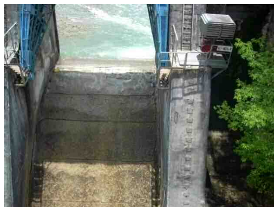
写真-4.2.2.3.3 ダムのゲート底部の状況
