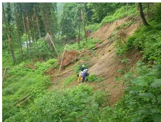
写真-4.2.1.6.8 滑落崖に露出する流れ盤の泥岩・砂岩
