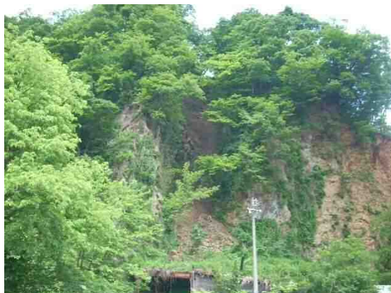
写真-4.2.1.3.4 小沢の土砂崩壊（B地点）
