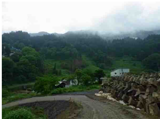
写真-4.2.1.6.1 八方岩地すべり全景
