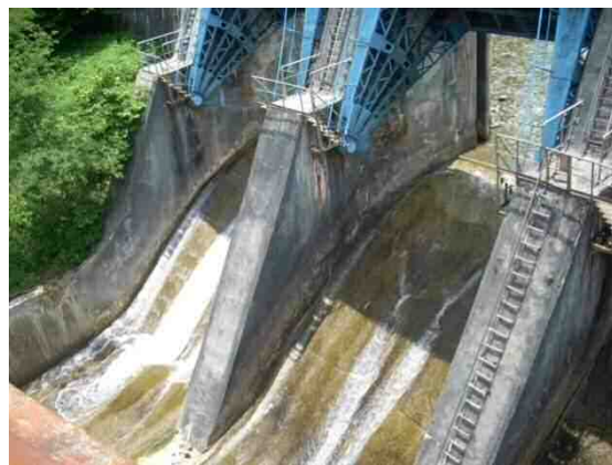
写真-4.2.2.3.2 ダムのゲート部
