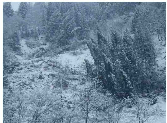
写真-4.2.1.6.7 西ブロック2末端の押し出し土砂
