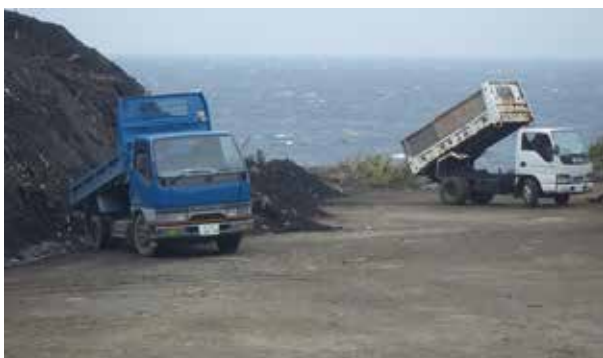
国民宿舎横：分別後の土砂の仮置き
