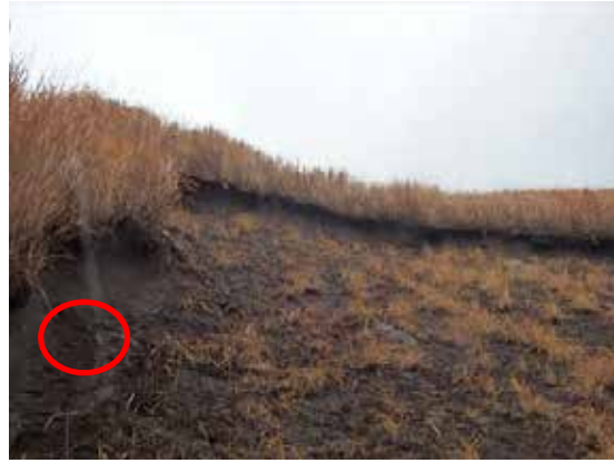
写真 3.3.4.7 試料採取箇所（崩壊右側部上方）
