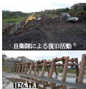
（大金沢本川堆積工）
