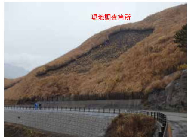
写真 3.3.3.11 現地調査を行った崩壊地(平成 24 年に発生)
