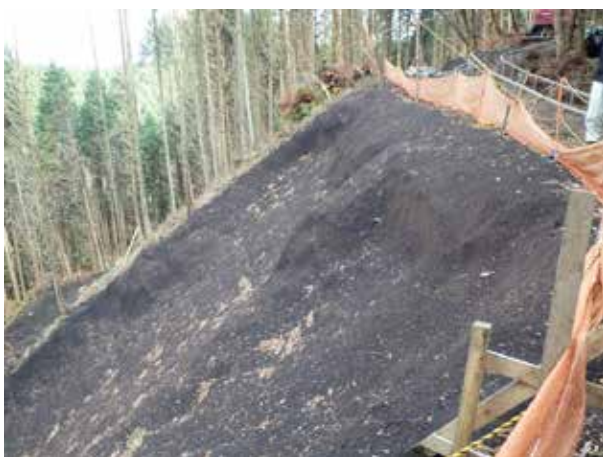
写真 3.3.3.8 植生基材吹付工による斜面对策状況
