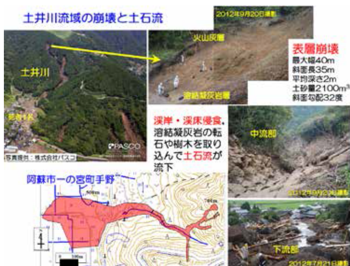
図 2.2.3 土井川流域の崩壊と土石流
