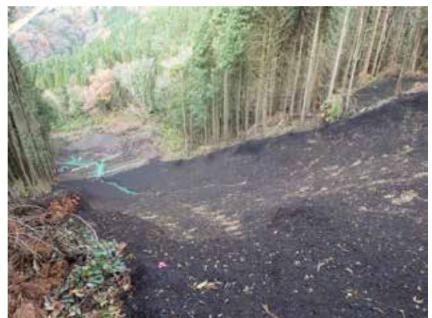
写真 3.3.3.8 植生基材吹付工による斜面对策状況
