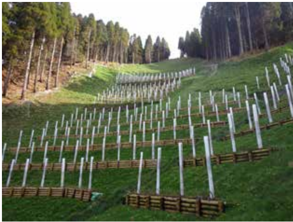
写真 3.3.3.9 木柵工と植生基材吹付工による斜面对策状況
