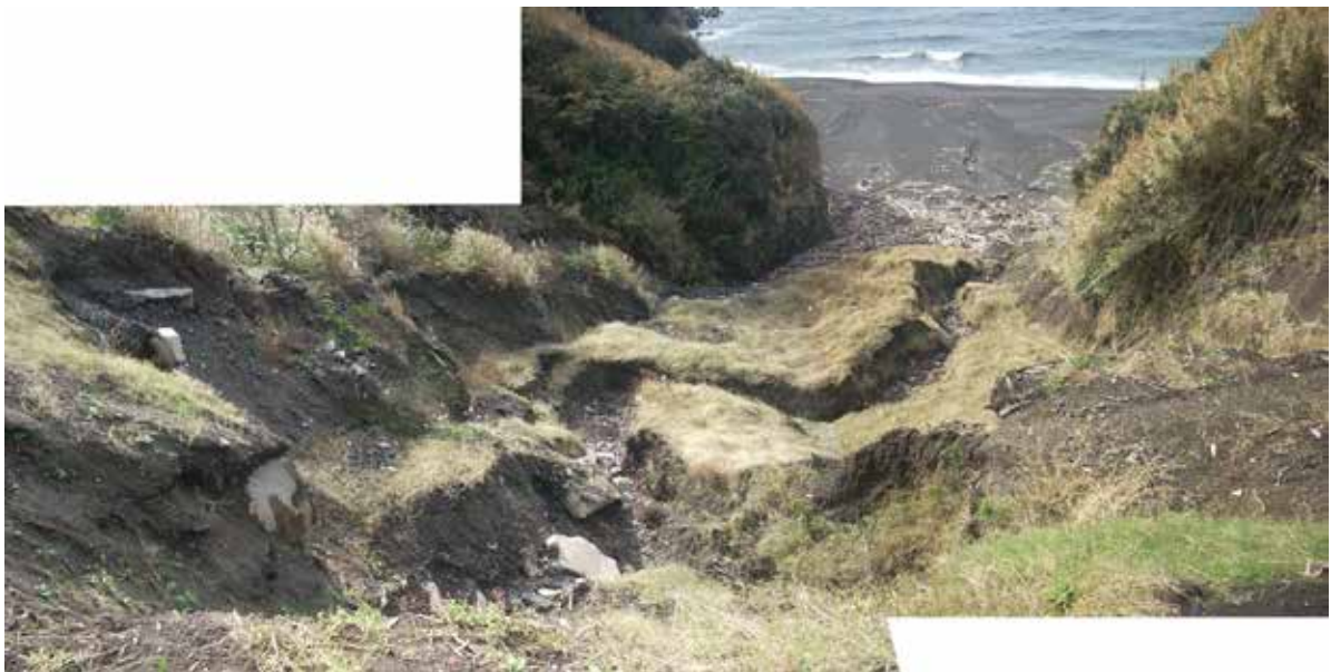
写真 2.3.3 国民宿舎横一次仮置場下の崖地の状況（平成 26 年 11 月 2 日現在）
