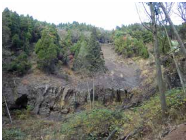
写真 3.3.3.3 崩壊地の遠景
