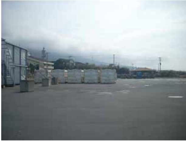
(a)元町港ヤードの状況（平成26年11月2日現在）
