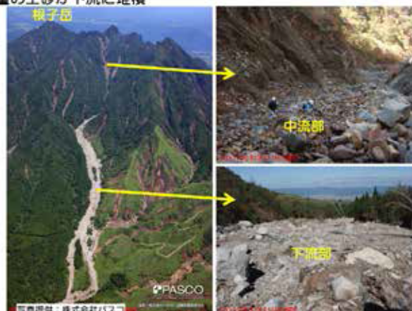
図 2.2.8 古恵川流域の急斜面の崩壊と土石流
