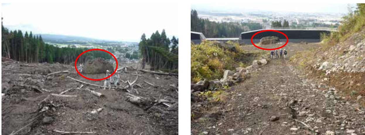
写真 3.3.8.3 砂防堰堤竣工前後の状況(上流側より望む、左：平成 24 年 9 月、右：平成 26 年 11 月) 赤印は土石流によって流下してきた巨石(径 3m×7m 程度)
