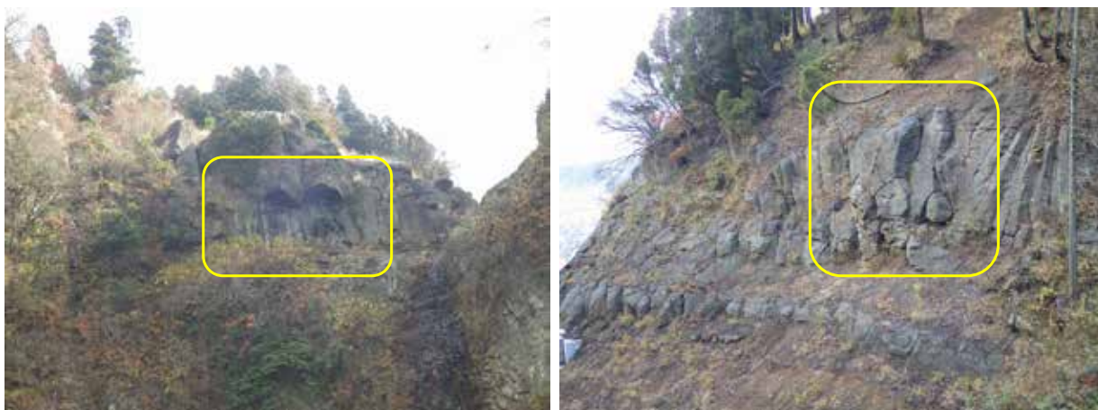
写真 3.3.6.4 節理面からの岩隕崩落箇所(左)とその兆候が認められる箇所(右)
