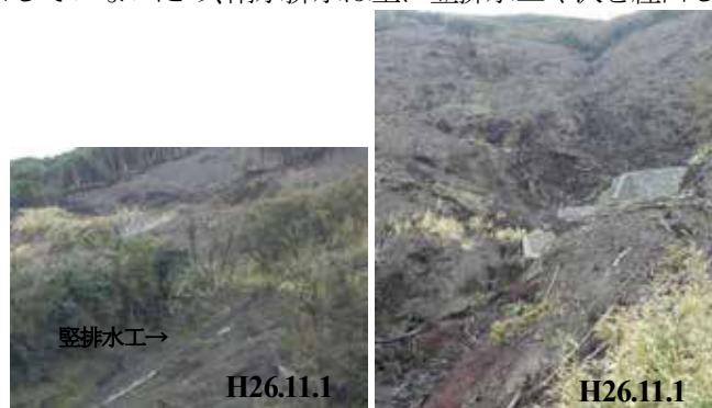
図 3.1.3.6 道路排水施設の復旧状況
