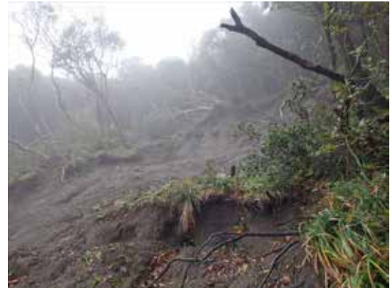
図 3.1.4.8 崩壊源頭部の状況
