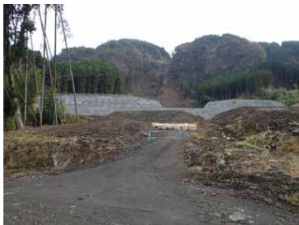
写真 3.3.3.1 砂防堰堤
