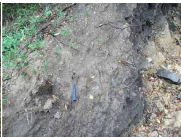
写真 1.4.3.2 庄原豪雨災害での表層の三瓶山火山灰黒ボク
