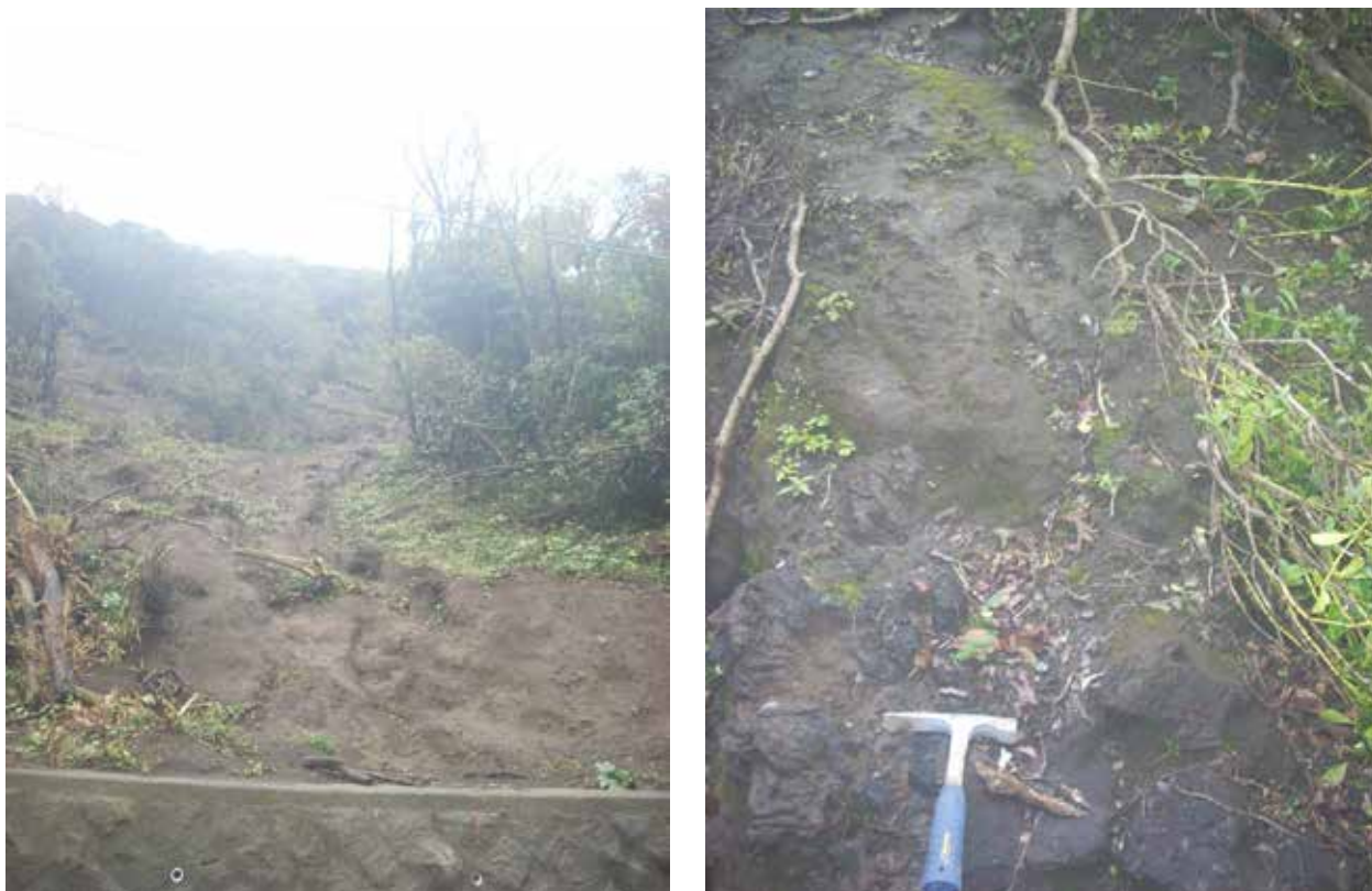
写真 2.3.6 崩壊跡地の土砂のサンプル：採取地全景（左）と採取した土砂（右：写真中の溶岩の上部の土砂）
