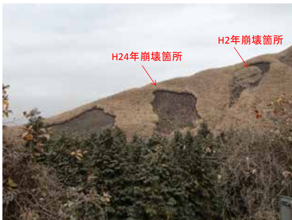
写真 3.3.3.10 平成 2 年と平成 24 年に発生した崩壊地
