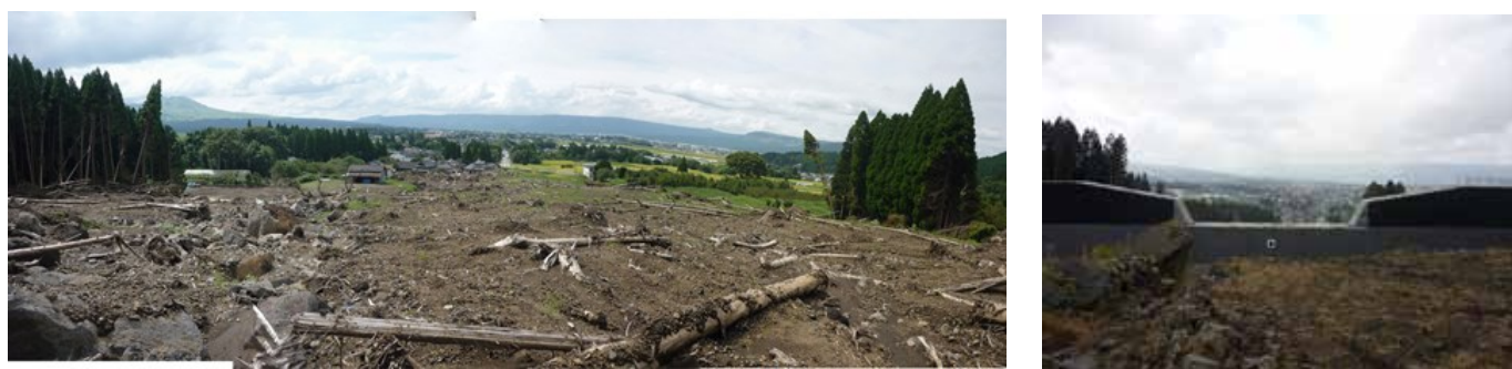
写真 3.3.8.2 砂防堰堤竣工前後の状況(上流側より望む、左：平成 24 年 9 月、右：平成 26 年 11 月)
