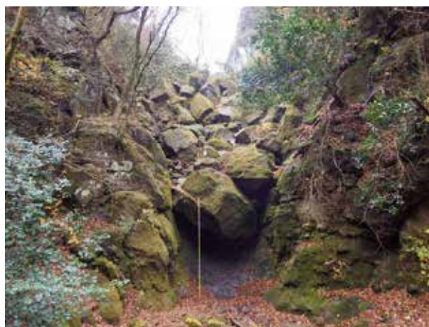
写真 3.3.6.9 巨石により閉塞した狭窄部 (塩井川 2)
