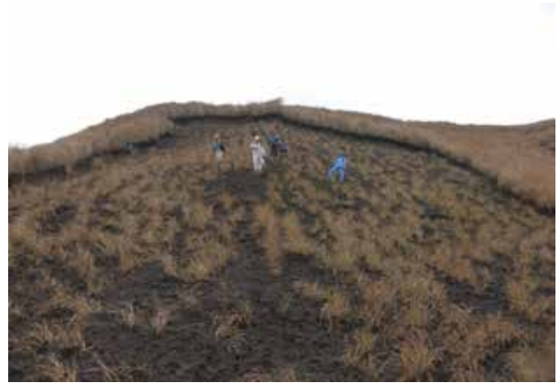
写真 3.3.7.8 平成2年7月の豪雨時に崩壊した斜面
