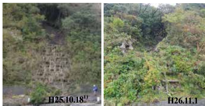
図 3.1.3.5 切土のり面工の復旧状況
