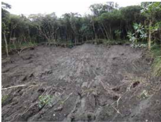
図 3.1.4.1 谷頭部の表層崩壊地の状況
