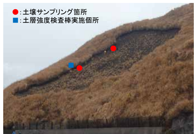
写真 3.3.4.6 試料採取箇所（崩壊右側部下方）
