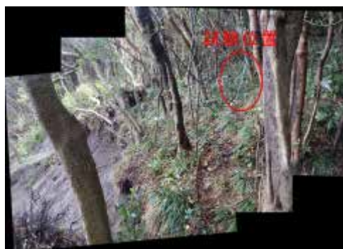
図 3.1.4.9 土層強度検査棒の試験位置
