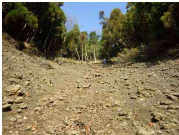
写真 3.3.3.4 崩壊地上部の状況
