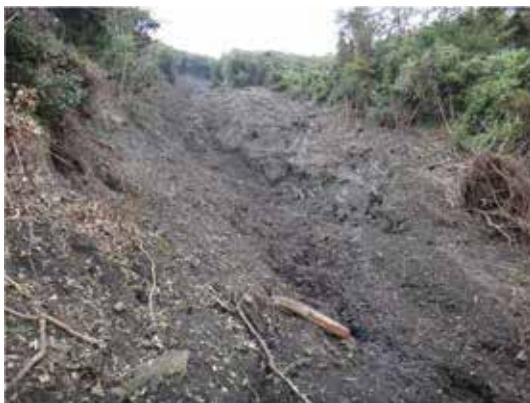
図 3.1.4.3 崩落土砂が流下した斜面の状況
