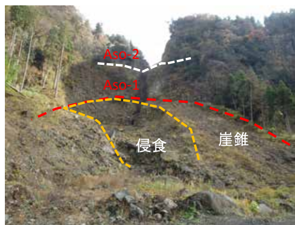
写真 3.3.3.2 砂防堰堤上流の土石流発生箇所の急崖状
