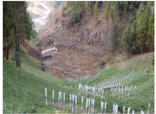
写真 3.3.3.9 木柵工と植生基材吹付工による斜面对策状況
