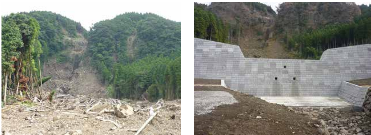
写真 3.3.8.1 砂防堰堤竣工前後の状況(下流側より望む、左：平成 24 年 9 月、右：平成 26 年 11 月)
