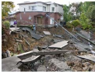
高町団地における谷埋め盛土崩壊の箇所 (67地点: 04.10.31)
