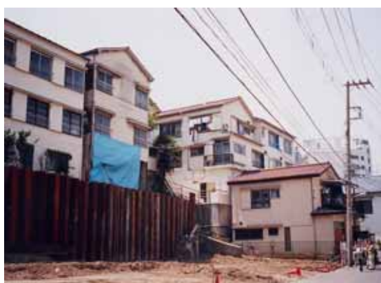
巡検当日のシートパイルによる山留め状況
