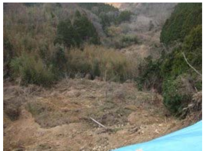
写真 5-2-5 道路決壊箇所 (S-26)
