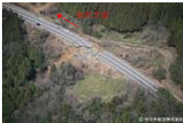
写真 5-2-14 14.7 km ポスト付近の崩壊（縦-21） （中日本航空殿提供）
