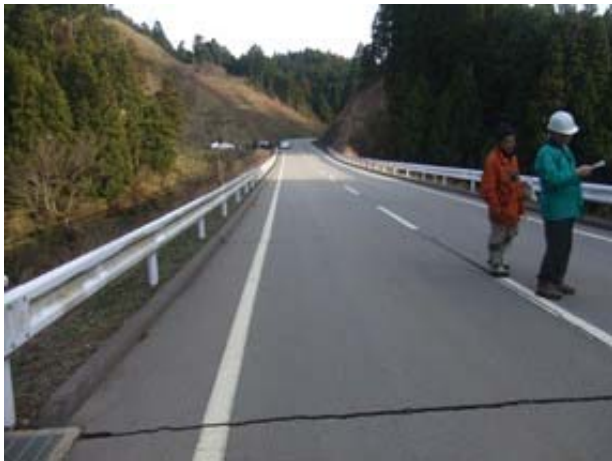
写真 5-2-20 着目した縦断勾配を有する盛土 手前：山側
