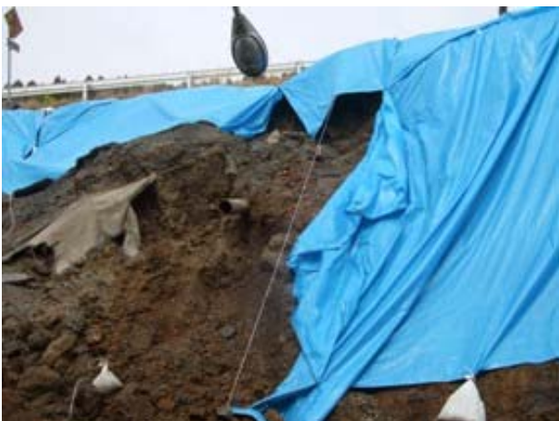
写真 5-2-12 横田 IC 付近の崩壊土塊（縦-10）
