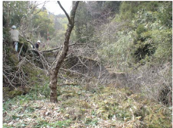
図 5.3.8 土石流を捕獲した治山ダム
