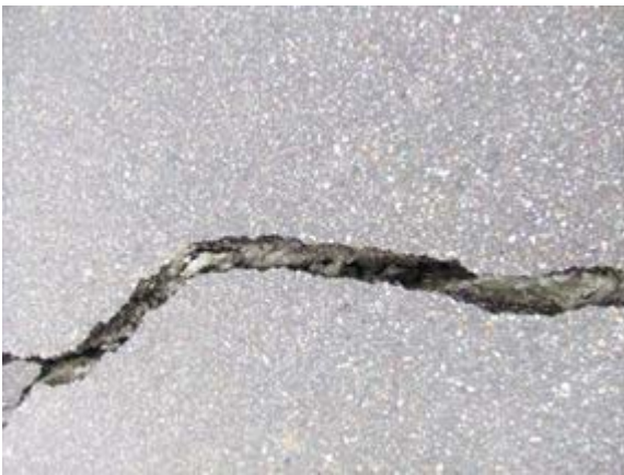
写真 5-2-2 道路のり肩の陥没と亀裂の状況 (S-10)
