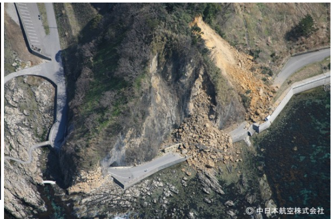
写真 5.1.7 隣接した 2 箇所の斜面崩壊(S-9 地点) (中日本航空株式会社撮影)
