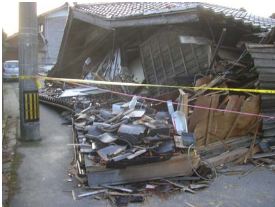
写真 4.3 小崖沿いの全壊した民家
