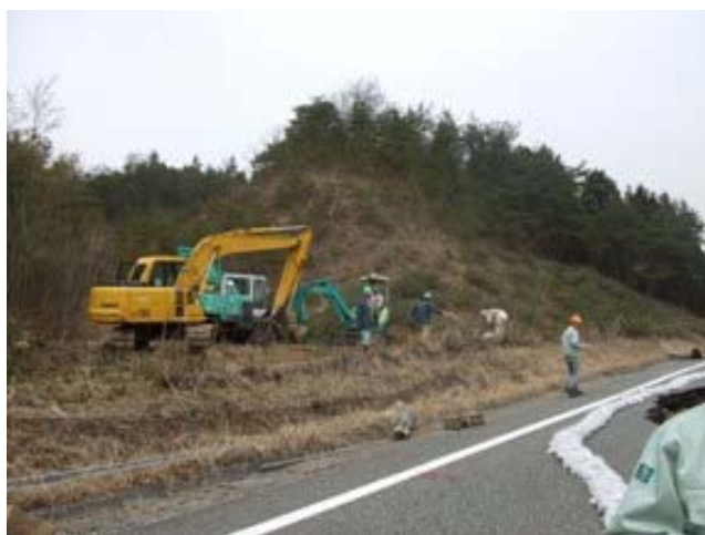
写真 5-2-17 崩壊頭部の林道（縦-21） 仮復旧としての迂回道路
