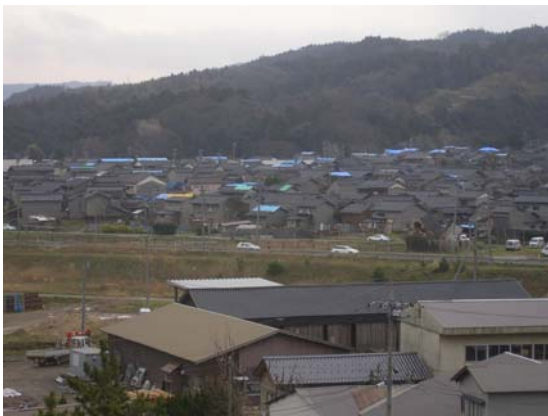
写真 4.1 宅地の地震被害が集中した門前町道下地区
