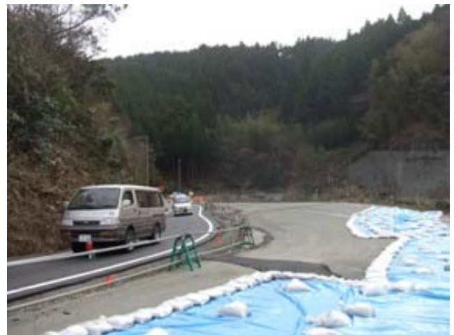
写真 5-2-2 道路のり肩の陥没と亀裂の状況 (S-10)
