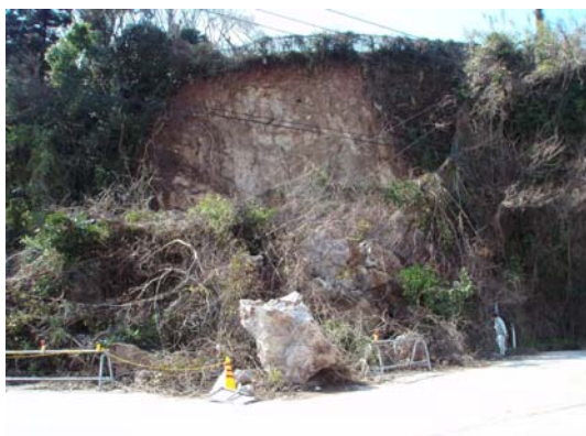
写真 5.1.1 正面から見た尾根状部の崩壊
