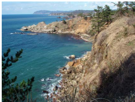
写真 5.1.3 関野鼻周辺の海食崖の崩壊
