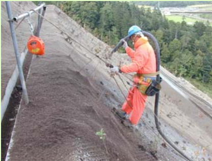
基材を吹き付けて根鉢を被覆する。
