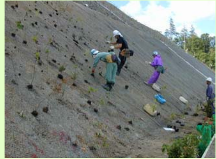
苗木をのり面に仮留めする。
