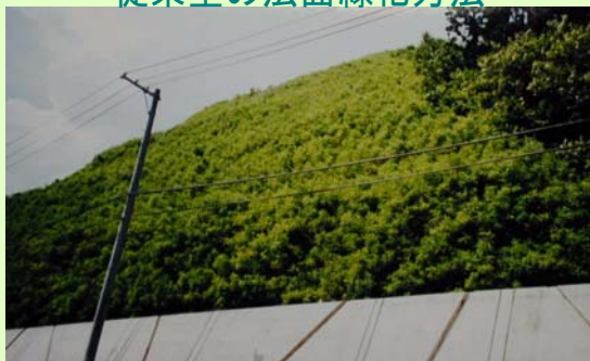
イタチハギが優占する法面(厚層基材吹付工)
