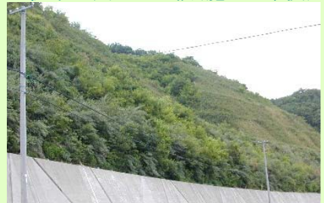
切土のり面ビオトープ工法は自然的な景観
