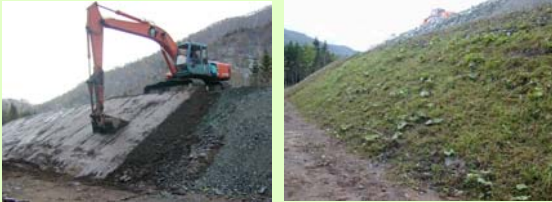
当社現場での施工状況 (北海道、千石Tでの事例)
