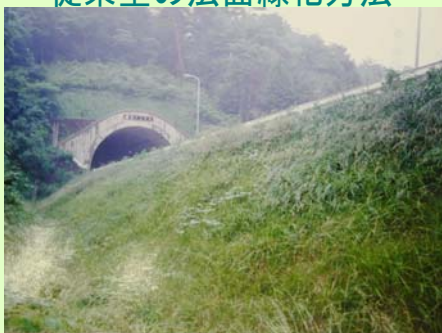
牧草類による緑化(厚層基材吹付工)
