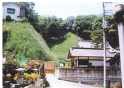
施工後2ヶ月程度
