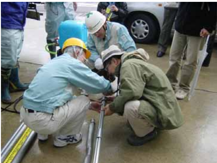
IMAGE013.jpg 2003/11/20 10:48:09 鋼管膨張型ロックボルト
