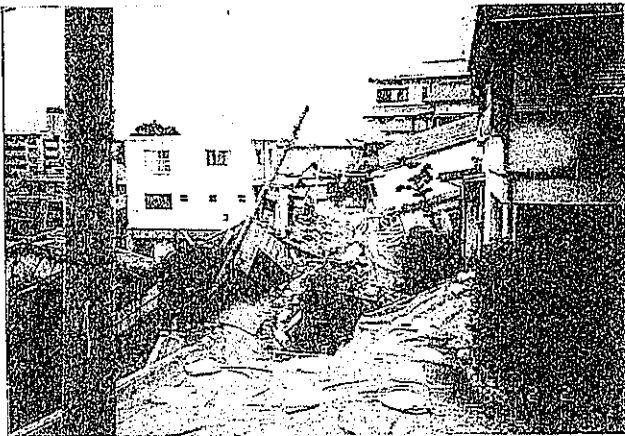
写真11 急斜面の崩壊 (D-Type)。2軒の民家が巻き込まれている。段丘崖の後退現象であり、一般に小規模であるが、移動速度が速く危険な斜面変動である (西宮市五月ヶ丘2/2)。
