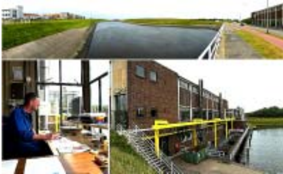
ライラント水管理委員会の管轄するカットヴィークの排水機場(右建物) ライラントのボルダーの水は、ここから絶えず北海に向けて排水される 写真下:排水機場の建物の裏側と、内陸側を管理するポンプのオペレーター
