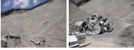
大地すべり末端:融雪の水で管きよと盛土が壊された。その時の仮排水量60立米/分
