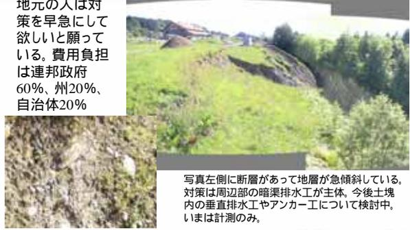
写真左側に断層があって地層が急傾斜している。対策は周辺部の暗渠排水工が主体。今後土塊内の垂直排水工やアンカー工について検討中。いまは計測のみ。
