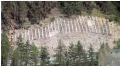
モルタル吹付工と鉄筋補強土工(基本的に防錆処理はなされない)
