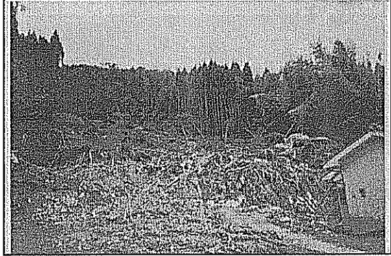
崩壊箇所の近景で、被災家屋のあったところ
