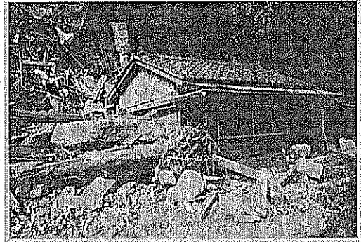
新屋敷土石流による家屋の被害
