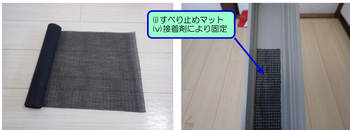
(f)雨どい底面への(i)すべり止めマットの取り付け
