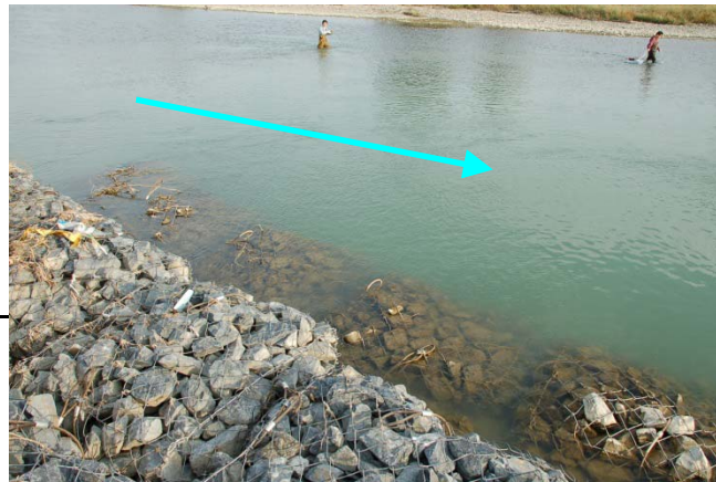
水制先端の様子
