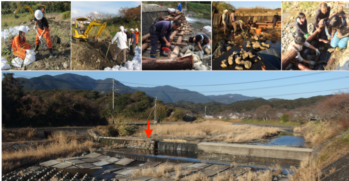
図-3 手づくり魚道設置状況
