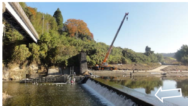
写真-1 日竹貯砂ダム（実験時に左岸側から撮影）
