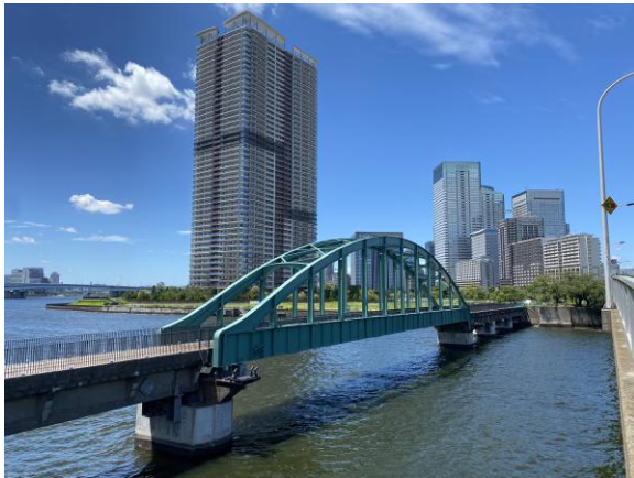
写真1 春海橋公園遊歩道(旧晴海鉄道橋)
