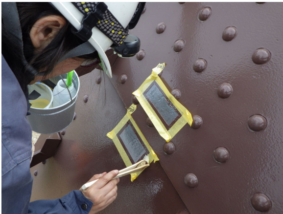
端部段差を解消の上、透明塗料を複数回塗布 ＜刻印の展示施工過程＞
