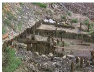
写真-4 大正時代の閘門構造物の下からでてきた明治時代の閘門構造物の基礎
