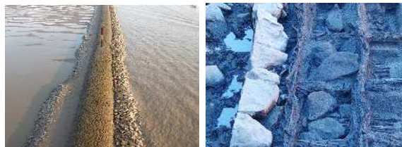
写真-5 (左) 筑後川の中央部にある石積の導流堤 写真-6 (右) 石積の基礎に使われている粗朶沈床
