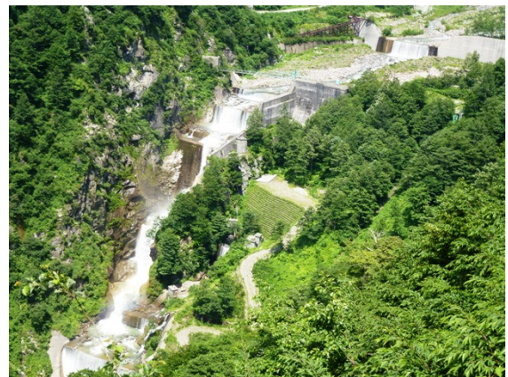
白岩堰堤砂防施設
