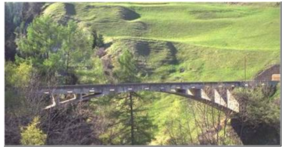
写真13 ファルツシールバッハ橋 1924年
