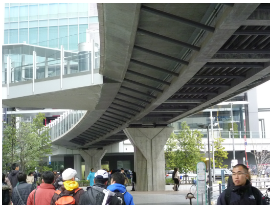
写真19 AKIBA Bridge の桁下の工夫
