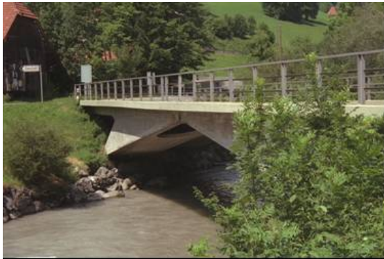
写真12 ガールシュタット橋 1940年
