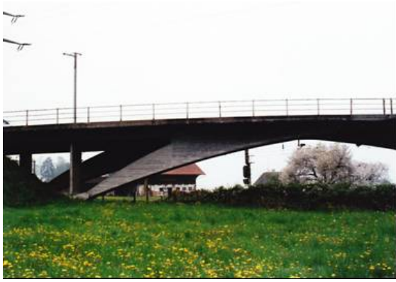
写真11 ラッヘン橋 1940年
