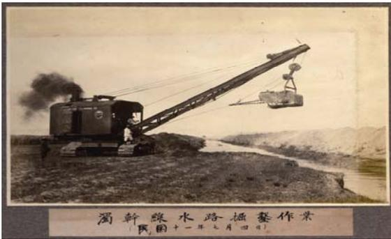
写真-5 記録写真 烏山頭工事で使われた大型土木機械
