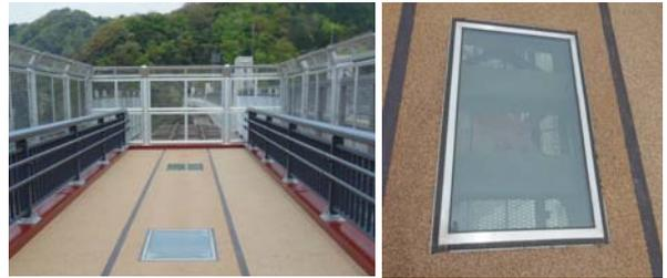
写真-8,9 鉄橋先端の保存区間と床面ガラス窓
