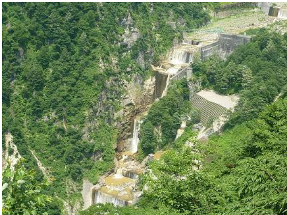
白岩堰堤砂防施設
