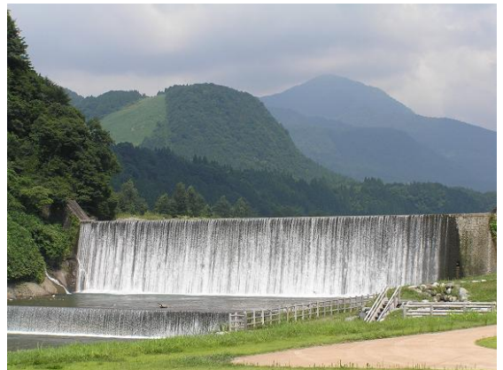
本宮砂防堰堤
