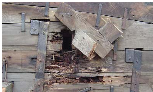
写真-3 アーチリブの腐朽状況
