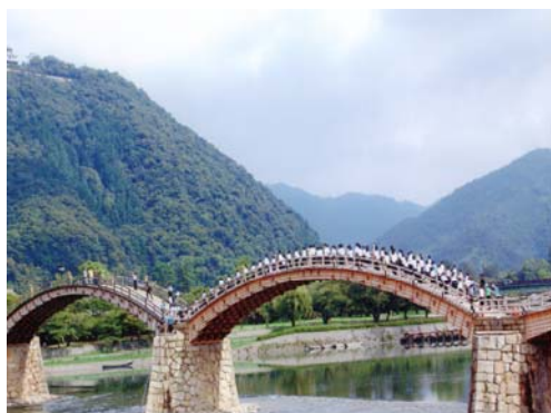
写真-2 地元の高校生による载荷試験
