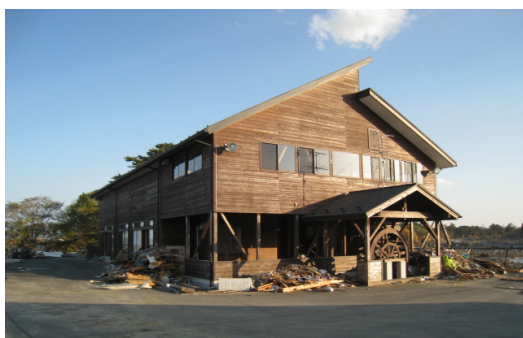
野蒜築港資料室
