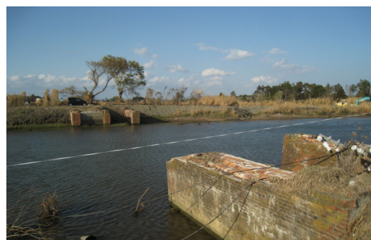
野蒜築港跡煉瓦橋台
