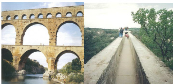
写真-1 ガール水道橋全景 写真-2 頂部の水路
