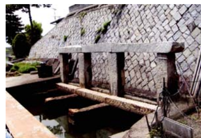
写真4 南蛮樋の大石樋 内川側の石組み
