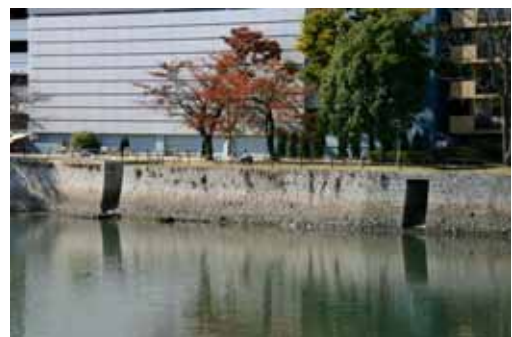
京橋川の護岸と雁木。精度の高い切込剥ぎは当時の石工の技術のうかがわせる
