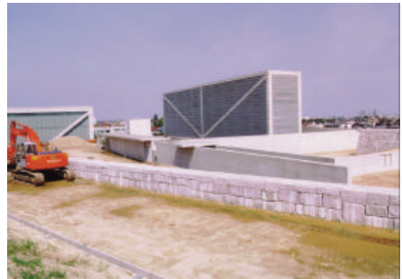
建設中の狭山池博物館
