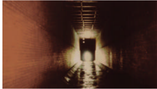
芝給水所の煉瓦造りの水路
