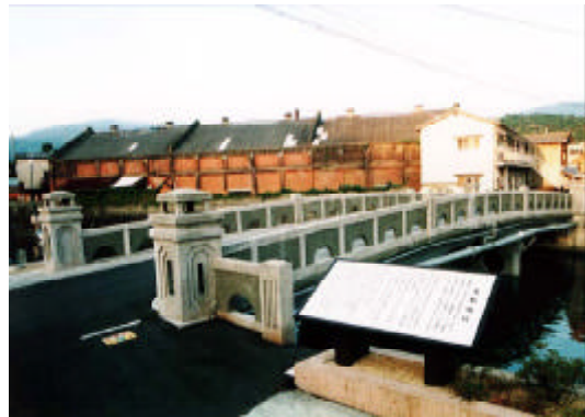
宮内川に架かる美名瀬橋 後方は旧東洋紡績川之石工場レンガ倉庫
