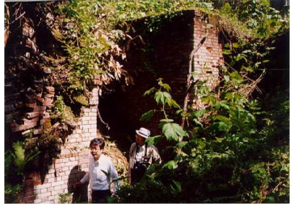
月形農場川に残された土堰堤の排砂門様構造物
