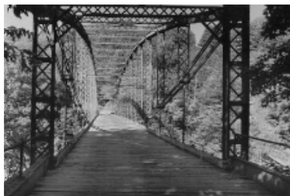
セントフランシス川橋（アーカンソー州） St. Francis River Bridge in Arkansas
