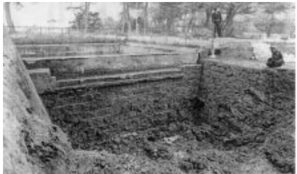
新たに確認された石積み—金沢城・二の丸跡—
