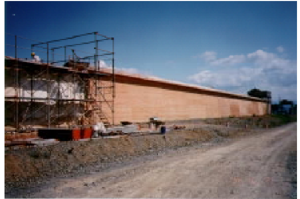
大和朝廷最北の基地志波城の保存整備工事
