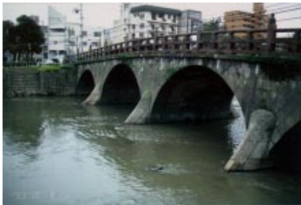
解体前の西田橋
