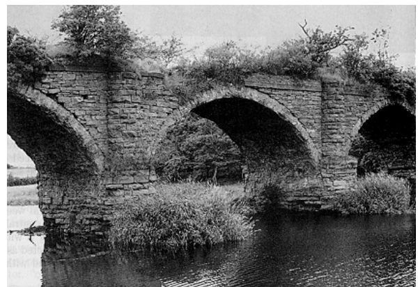
レイ・ミルトン高架橋（Laigh Milton viaduct）
