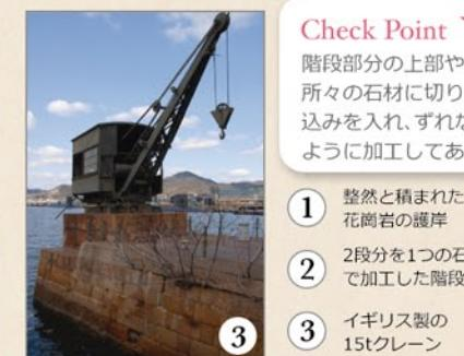
明治19(1886)年、呉港に鎮守府を設置することが決定すると、呉湾の沿岸部は軍用地として買い上げられ、明治22(1889)年に呉鎮守府が開庁した。鎮守府庁舎の南側には造船部が設置され、さらに南側の岬をまわった先の浜辺を埋め立てて兵器部が設置された。なお、これらが東洋一の規模と言われた、のちの呉海軍工廠となる。兵器部の工場建設のために整備された石造護岸には、明治25(1892)年に魚形水雷発射試験場が、明治30(1897)年までに潜水艦桟橋が、その他に上陸場、荷揚場、英國製の15tクレーンなどが設置された。現在、水雷の発射施設等は撤去されているが、それらが取り付けられていた石積みの土台等は現存し、所々に船繫ぎ石や係留用の金具が残されている。石造護岸は延長約300mで、呉の対岸の倉橋島で産出される「倉橋みかけ」と呼ばれる花崗岩を、縦45cm×横90cmと縦横45cmの2種類に切り出し、それらを交互に整然と積み上げている。特に階段部分は2段分を一つの石材から切り出して、隣接する石材と巧みに組み合わせられており、石工の技術の高さを見ることが出来る。
