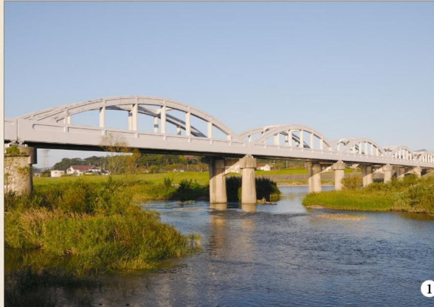
① 5連のアーチが美しい高角橋 ② 手前が追加された桁橋 ③ アーチと桁の側面には凹凸があり、橋詰めの高欄には尖塔アーチの模様がある
