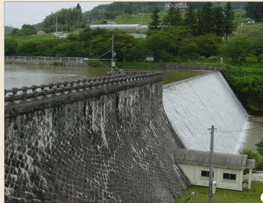
① 表面の石積みによる重厚な外観と流水の表情が美しい千本堰堤 ② 曲線を取り入れたデザインの弁室 ③ 幾何学的な造形の堤頂部の高欄
