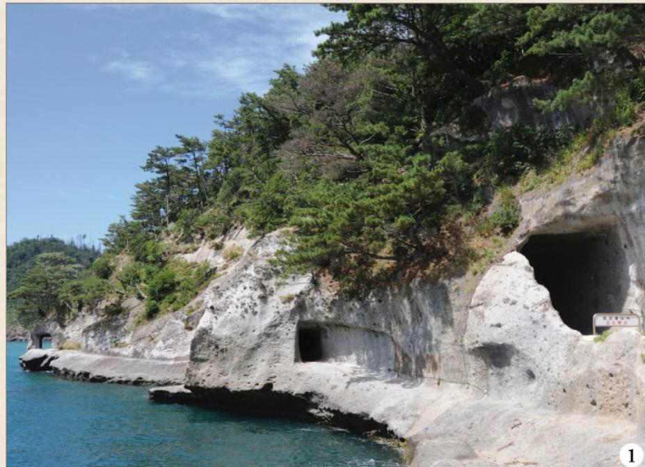
隠岐の島は、急峻な山地が海岸部まで迫り、平地が少なく、島を周回する道路は現在でも、幅員が狭くてカーブが多い。島後北西部に位置する重複湾には、標高300mほどの半島が突き出ており、福浦と五箇を結ぶ交通を阻害してきた。明治の初め頃までは、徒歩で黒滝岩の峠を越えるか、船を利用するか、あるいは危険を冒して磯伝いに迂回するしかなく、どれも天候や季節に左右されやすく、遭難者が出ていたと言われている。そこで、断崖を縫うように2ヶ所のトンネルが掘られた。トンネル付近は比較的軟らかい凝灰岩で、鑿[たがね]や鶴嘴[つるはし]によって人力で掘られており、長さは7.5mと4.2m、断面は幅1.3m、高さ1.8mの四角形である。建設年代は明らかでないが、明治の初め頃と伝えられている。トンネルの前後は、岩場をそのまま利用したり、海面から2、3mの位置の岩肌を削っただけの人ひとりがやっと通れるだけのわずかな幅の道で、現在、その道の下は波の浸食によって削られ、海面が潜り込んでいる。
