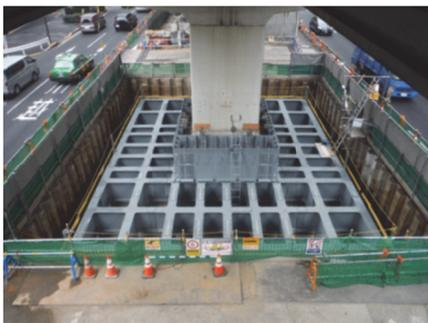
写真-1 鋼製格子部材の設置完了状況
