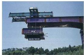
移動クレーンによる張出し架設
