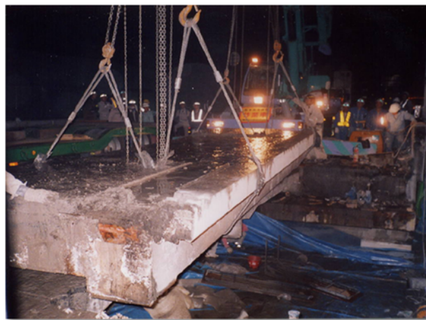
図－8 R C橋梁の撤去工事
