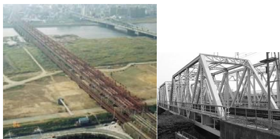
写真 3 A 橋の外観
