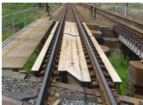
写真 1 槽状桁の例
