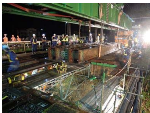
写真 2 桁交換機による施工状況
