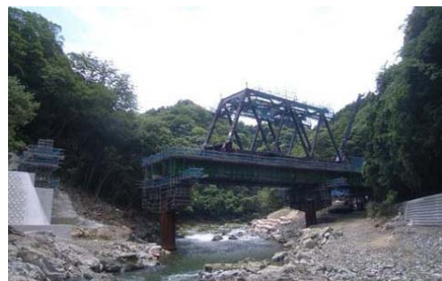
写真 4 B 橋施工状況（架設桁工法）
