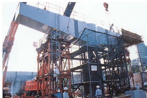
図－6 R C柱－鋼製梁の複合橋脚
