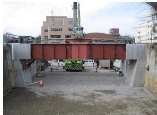
写真 7 既設鋼橋と橋台の一体化構造
