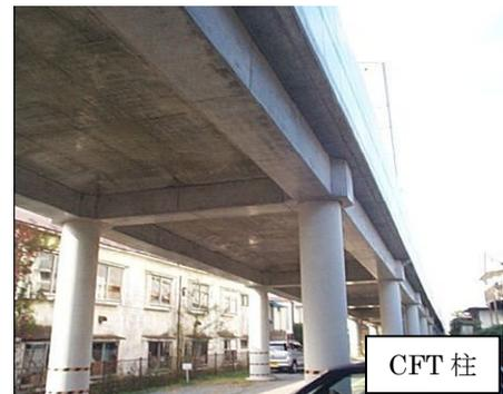
写真 6 CFT 構造
