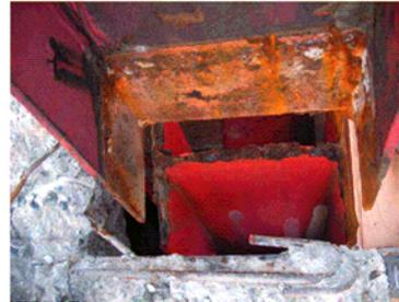
コンクリート中に埋め込まれた鋼部材に腐食が発生し、破断に至った例
