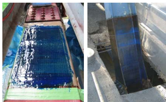
(a) 下弦材（浅利橋） (b) 斜材（本城橋）
