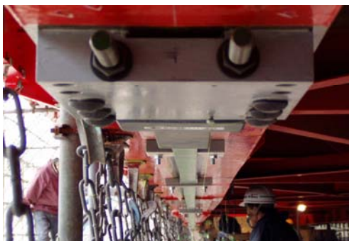
図-2 主桁下フランジへの適用例（山倉橋）
