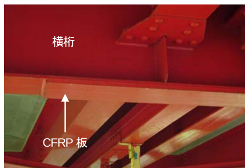
図-1 横桁下フランジへの適用例（桜の目橋）
