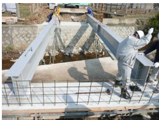
図-4 主桁架設
