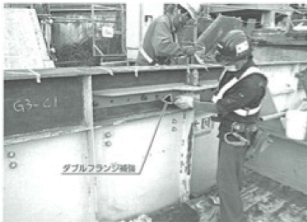
写真-2 ダブルフランジ補強
